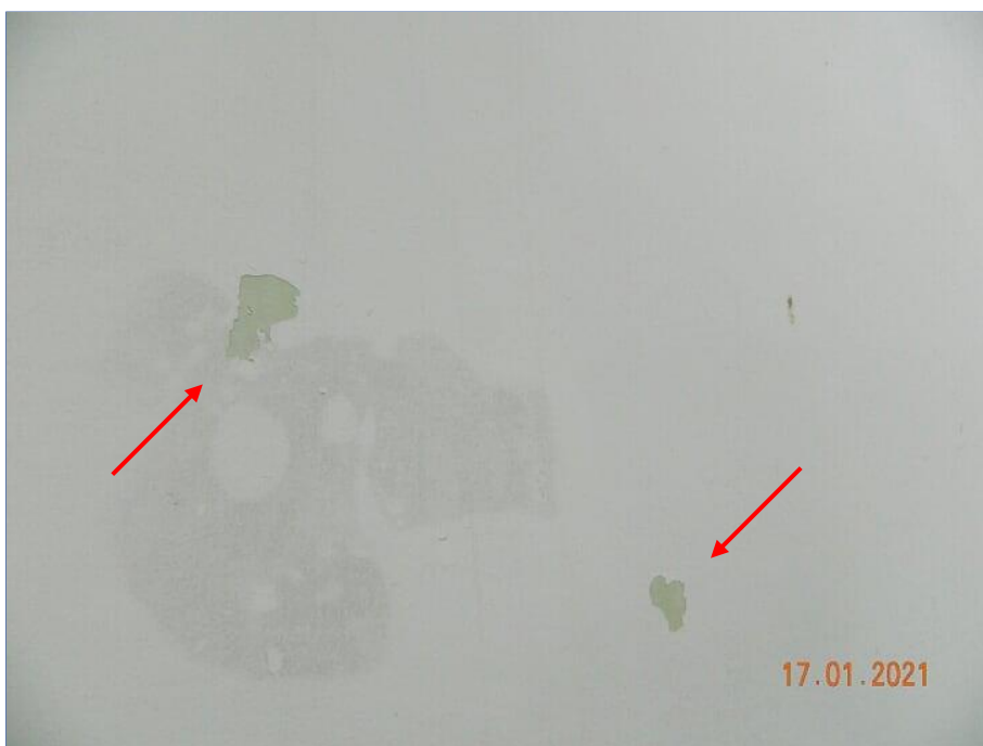
FOTO Nº 083: Descascamento de pintura.
