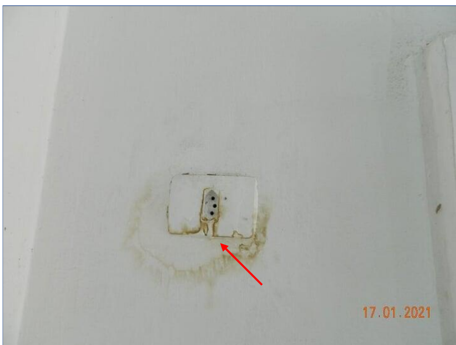
FOTO Nº 016: Sinal de infiltração na instalação elétrica.
