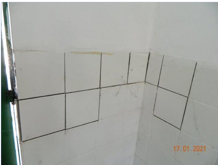
FOTO Nº 093: Revestimento desconforme do original, sem aplicação de rejunte.
