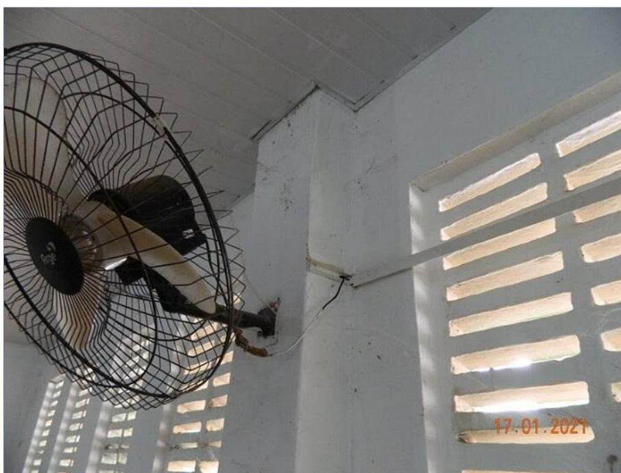
FOTO Nº 089: Instalação elétrica irregular.
