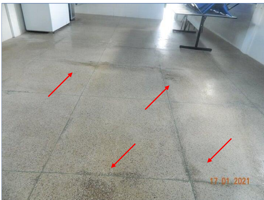
FOTO N° 182: Piso do refeitório manchado por umidade.
