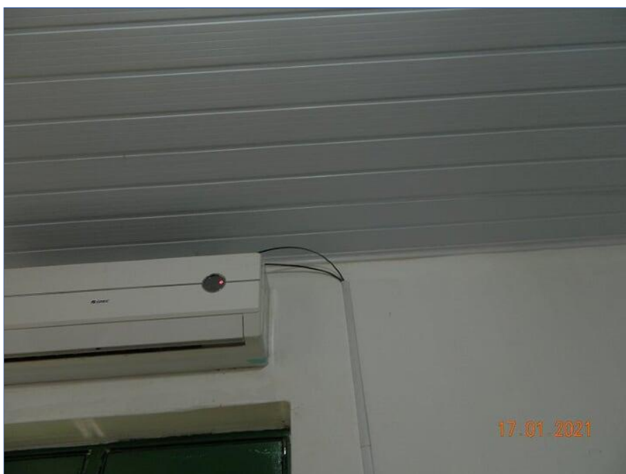
FOTO Nº 062: Instalação elétrica irregular.
