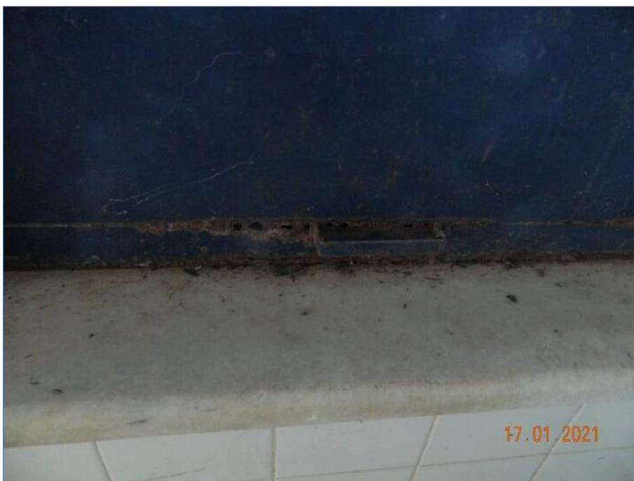
FOTO Nº 176: Esquadria metálica danificada com sinal de ferrugem.
