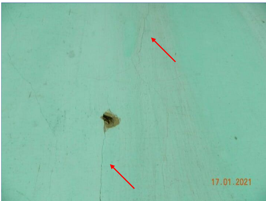
FOTO Nº 166: Parede danificada e fissurada.
