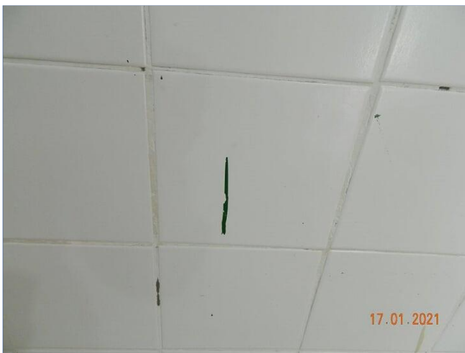
FOTO Nº 019: Revestimento cerâmico danificado por tinta.
