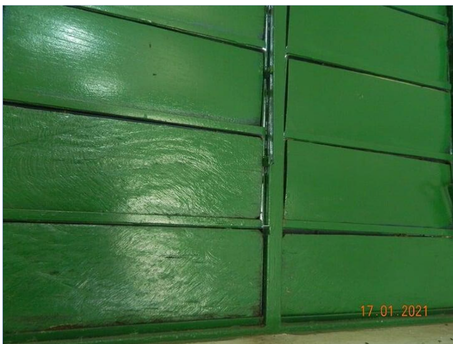
FOTO Nº 017: Detalhe: Fechamento em madeira da esquadria metálica.
