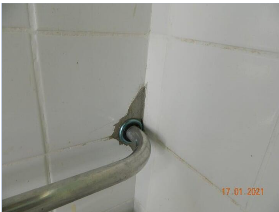
FOTO Nº 121: Revestimento cerâmico danificado.
