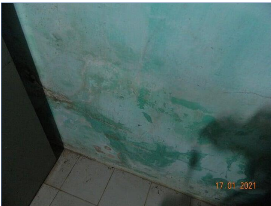
FOTO Nº 165: Sinal de infiltração.
