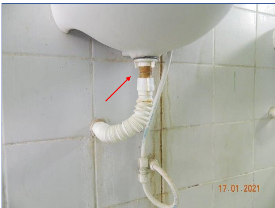
FOTO Nº 126: Instalação hidrossanitária irregular com sinal de deteriorização.
