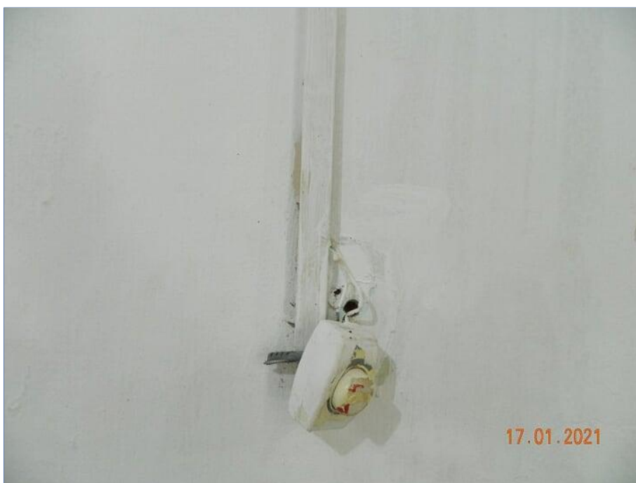
FOTO Nº 081: Instalação elétrica irregular.
