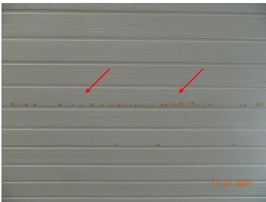
FOTO Nº 082: Sinal de infiltração no forro.
