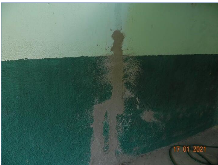
FOTO Nº 157: Parede danificada.
