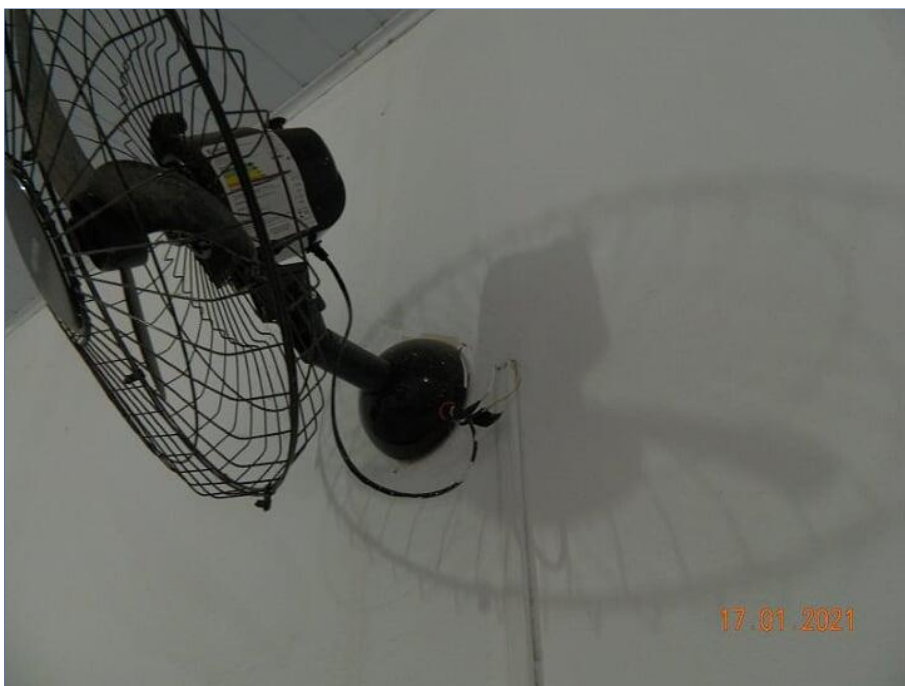
FOTO Nº 059: Instalação elétrica irregular.
