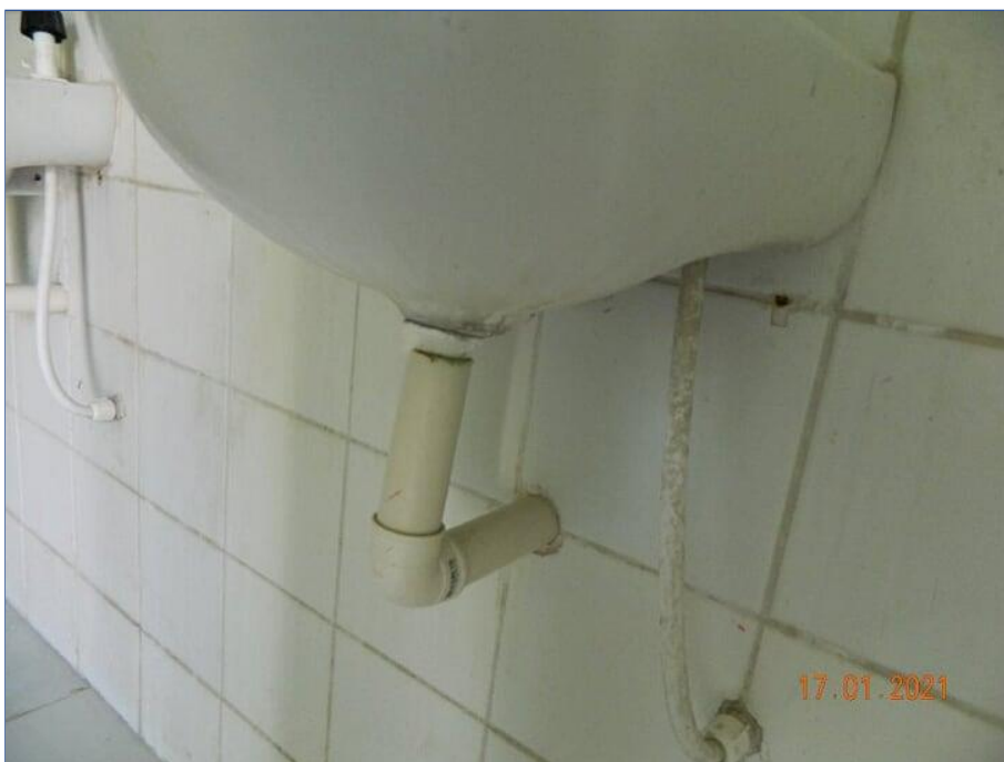
FOTO Nº 136: Instalação hidrossanitária irregular.
