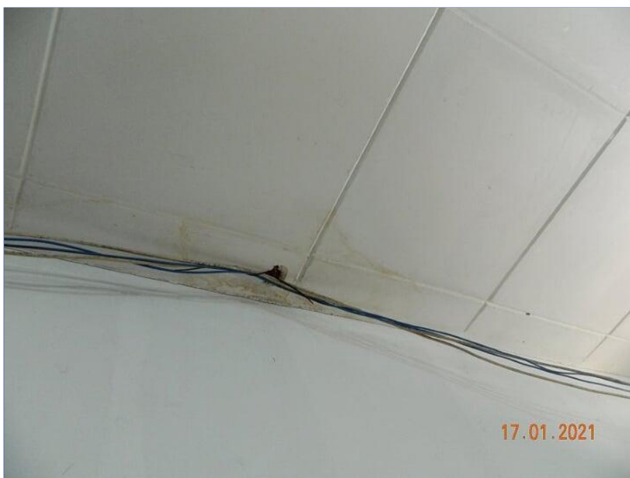
FOTO Nº 069: Forro danificado para fixação irregular da instalação de lógica com sinal de infiltração no forro.
