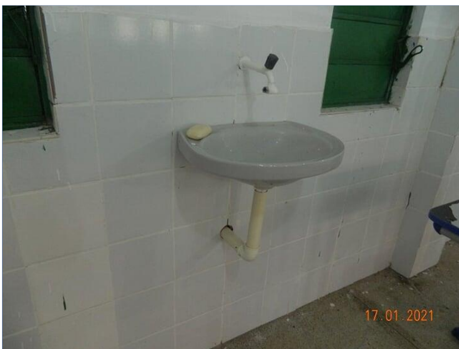
FOTO Nº 111: Vista geral: Sistema hidráulico instalado no interior da sala de aula 06.
