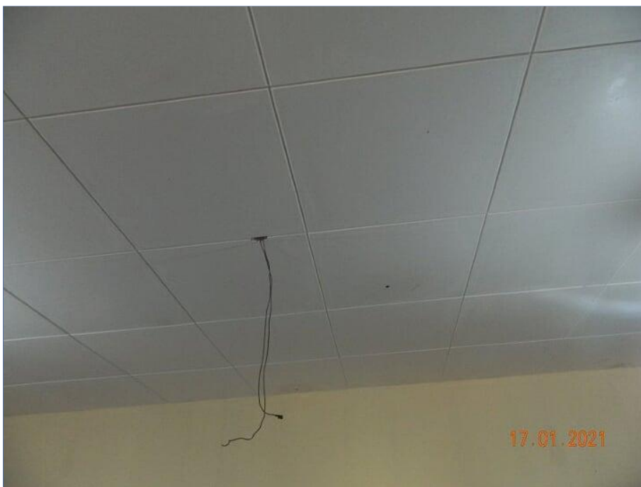
FOTO Nº 151: Instalação elétrica irregular.
