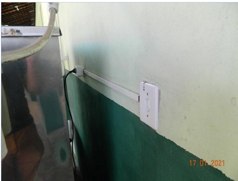
FOTO Nº 131: Instalação elétrica irregular.
