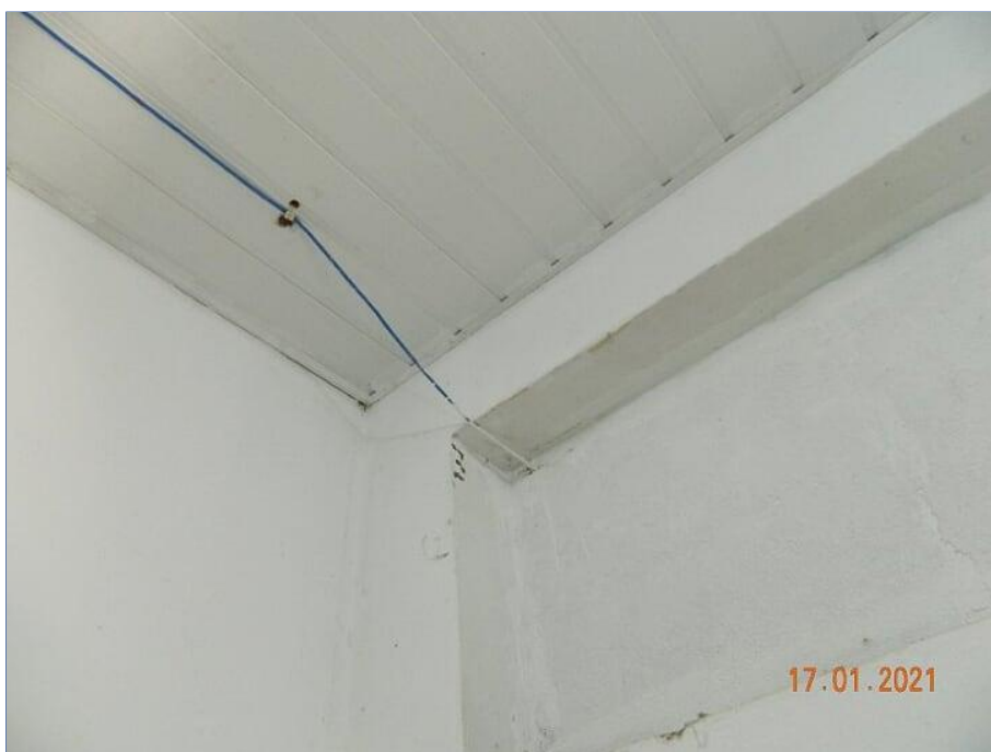
FOTO Nº 079: Forro e Parede danificados para fixação e instalação de lógica irregular.
