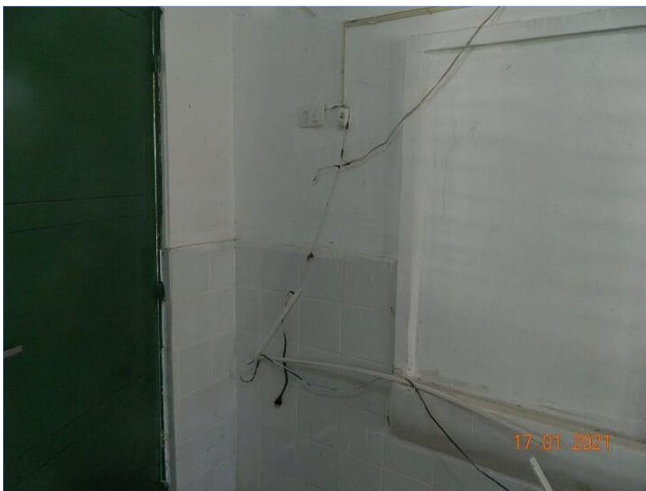
FOTO Nº 103: Instalação elétrica irregular.
