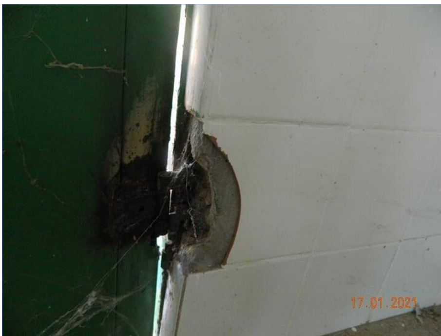
FOTO Nº 095: Fixação da porta metálica irregular e parede com revestimento cerâmico danificado.
