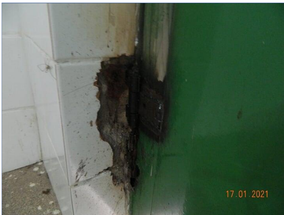
FOTO Nº 076: Fixação da porta metálica enferrujada e avaria na parede.
