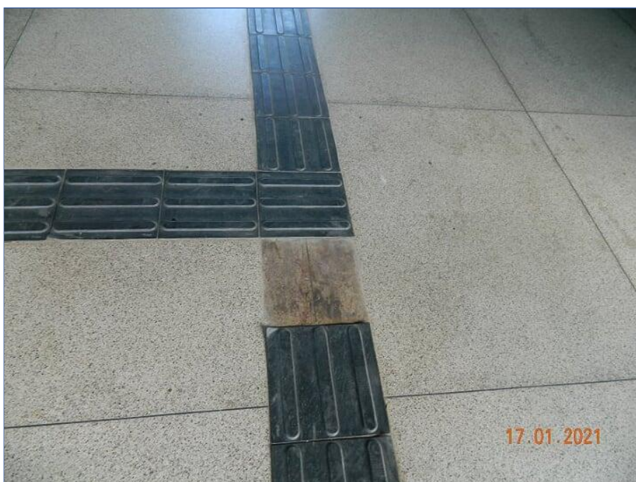
FOTO Nº 032: Piso tátil com sinal de descolamento, assim como ausência de uma peça.
