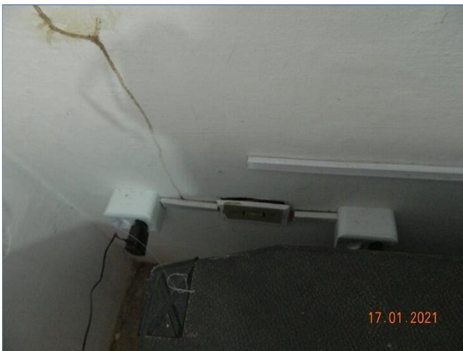
FOTO Nº 060: Instalação elétrica irregular e sinal de manifestação de inseto.
