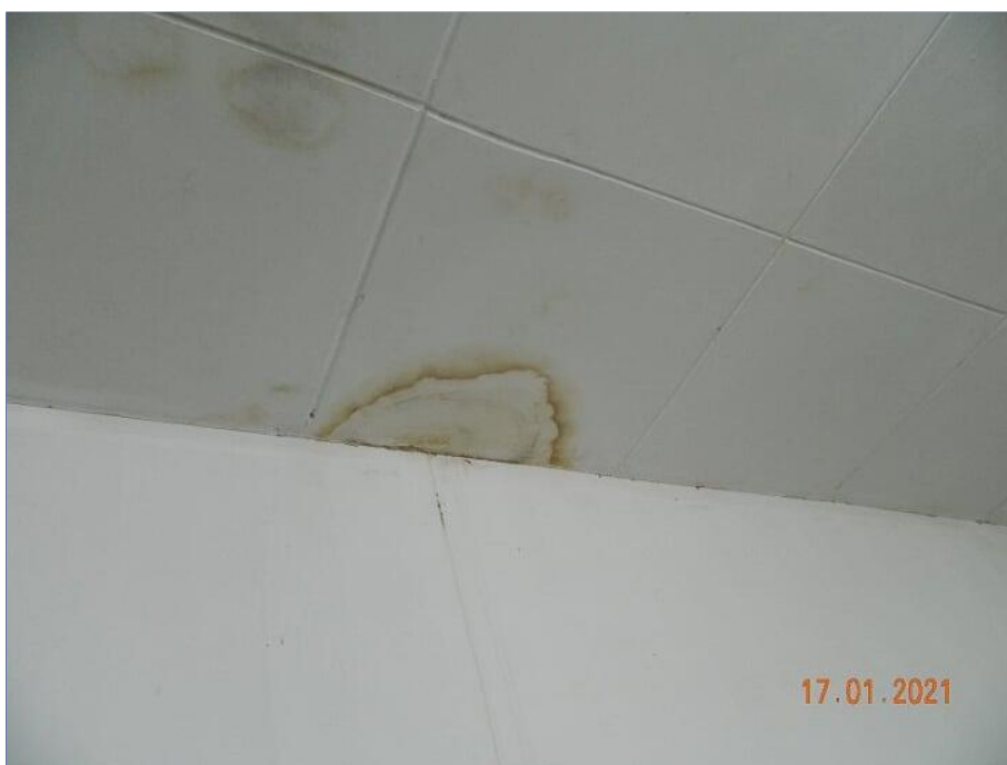
FOTO Nº 071: Sinal de infiltração no forro.
