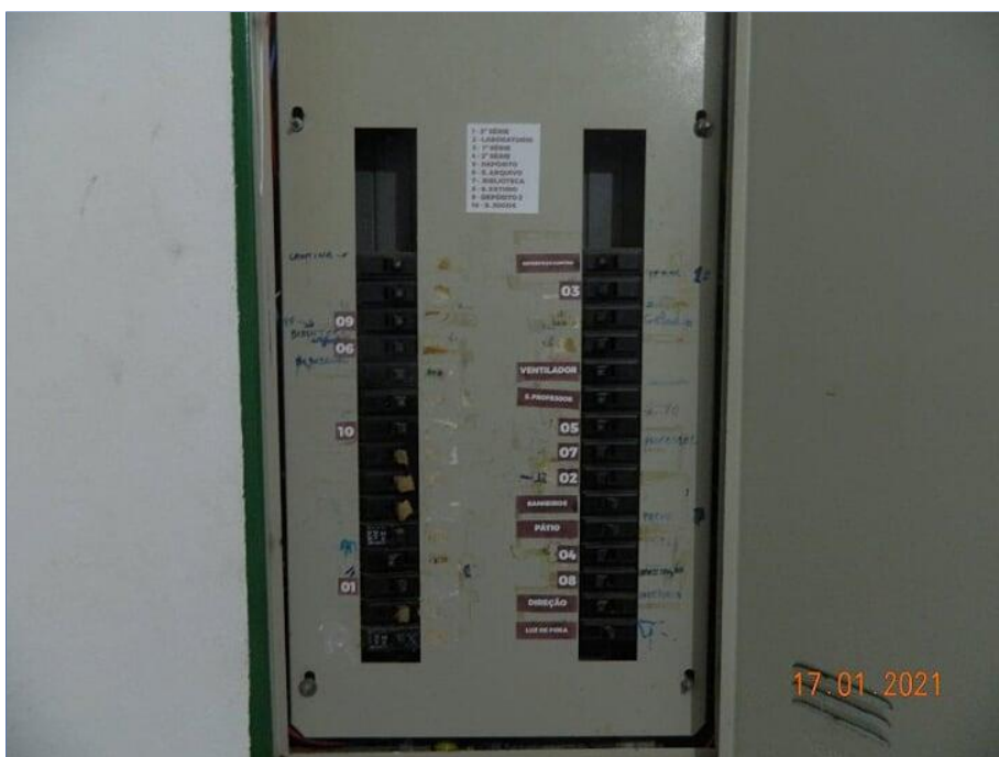
FOTO Nº 043: Quadro elétrico com identificação irregular.
