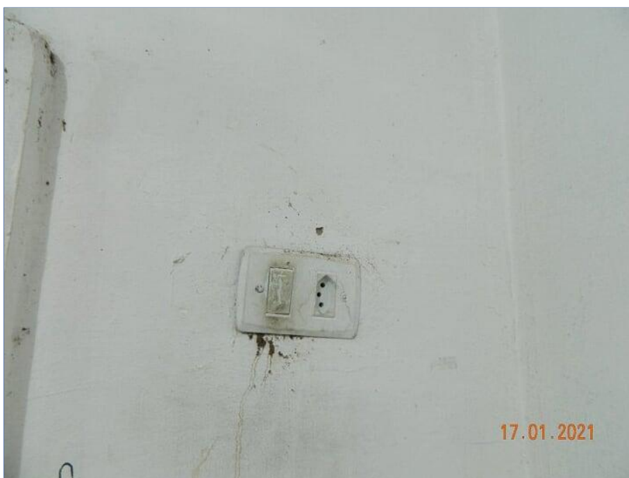
FOTO Nº 013: Instalação elétrica deteriorada.
