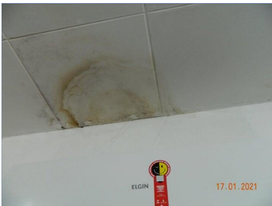
FOTO Nº 072: Sinal de infiltração no forro.
