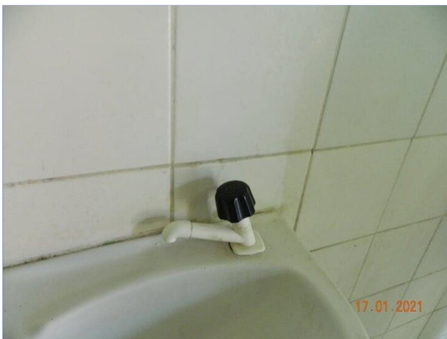
FOTO Nº 137: Instalação hidrossanitária danificada.
