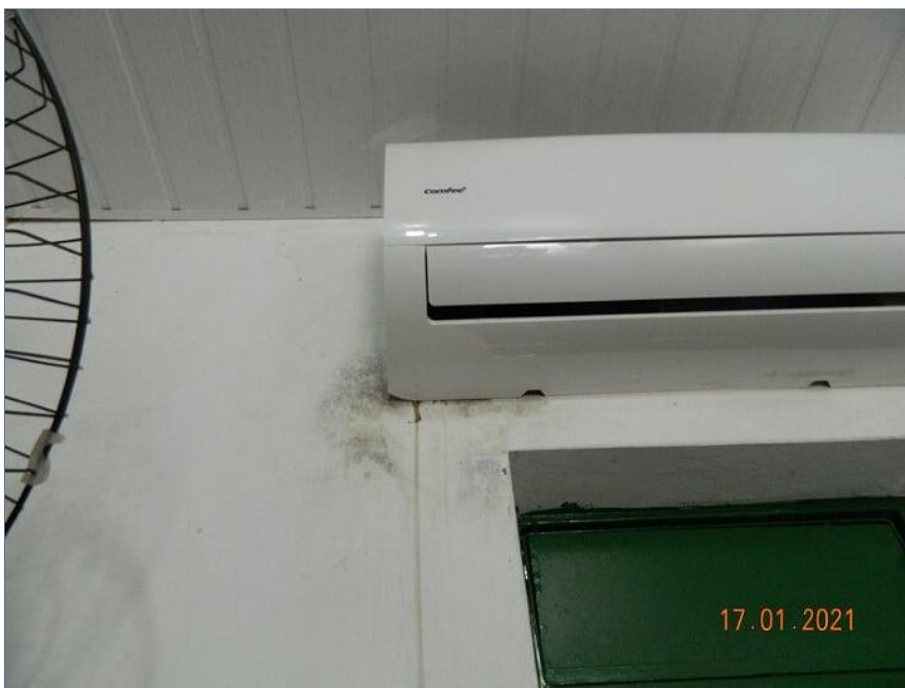
FOTO Nº 029: Sinal de infiltração de água proveniente da instalação do ar condicionado, com formação de bolor.
