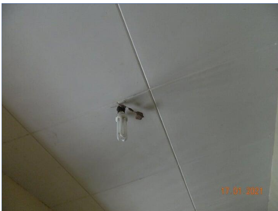
FOTO Nº 052: Instalação elétrica irregular.
