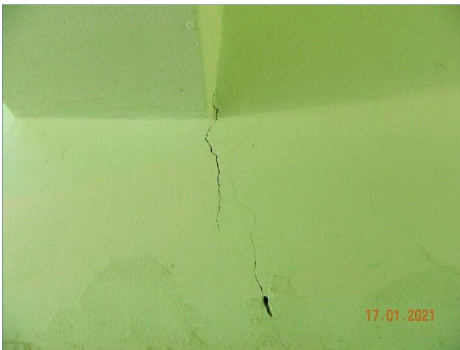
FOTO Nº 127: Trinca na parede.
