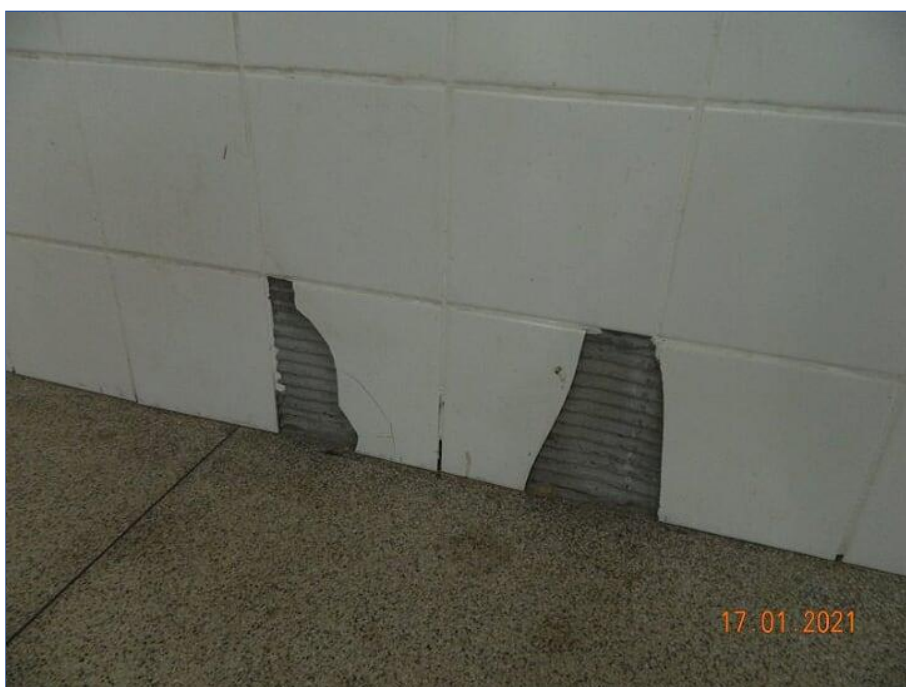
FOTO Nº 084: Revestimento cerâmico danificado.
