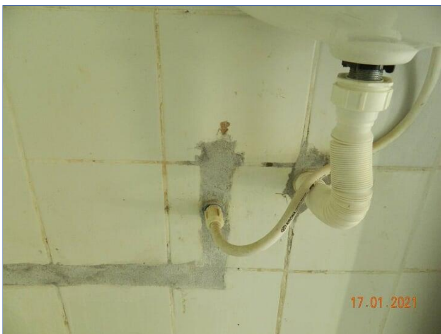
FOTO Nº 120: Revestimento cerâmico danificado.
