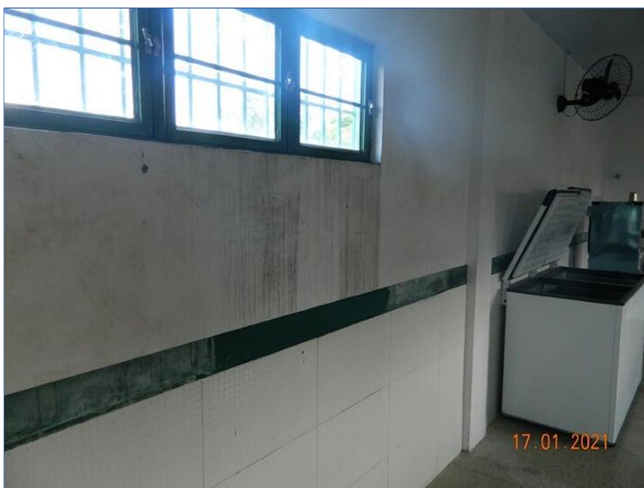
FOTO Nº 180: Sinal de infiltração na parede.
