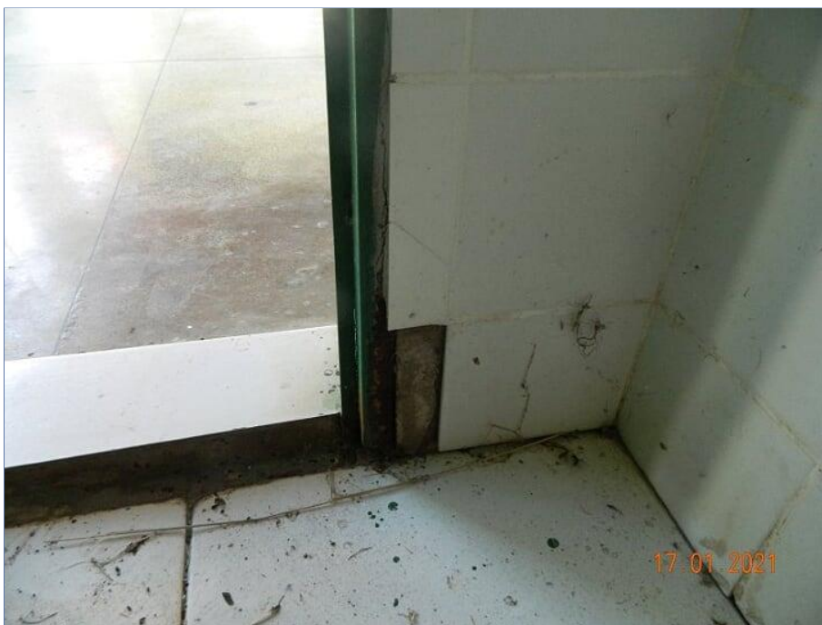
FOTO Nº 129: Revestimento cerâmico danificado.
