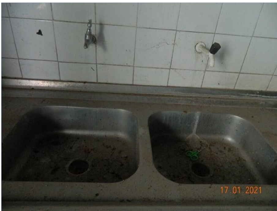
FOTO Nº 175: Instalação hidrossanitária danificada, obstruída por sujeira.
