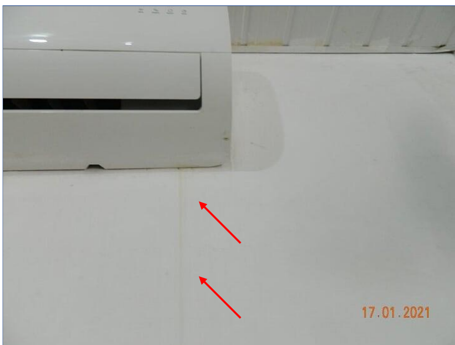
FOTO Nº 020: Sinal de infiltração de água proveniente da instalação do ar condicionado.
