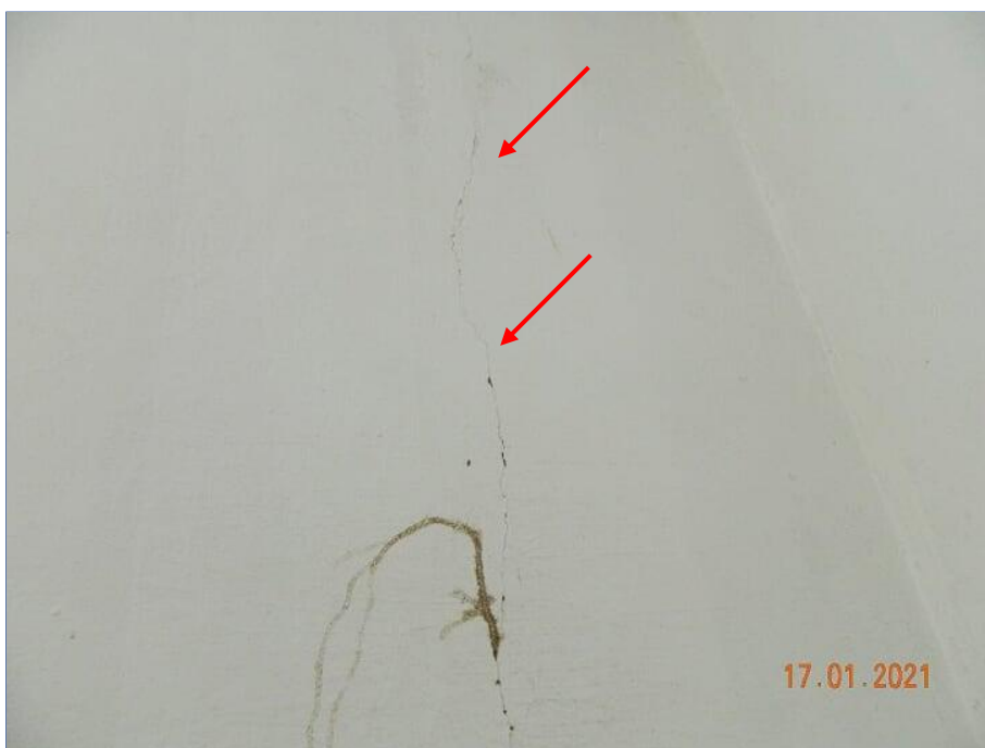
FOTO Nº 061: Trinca na parede e sinal de manifestação de inseto.
