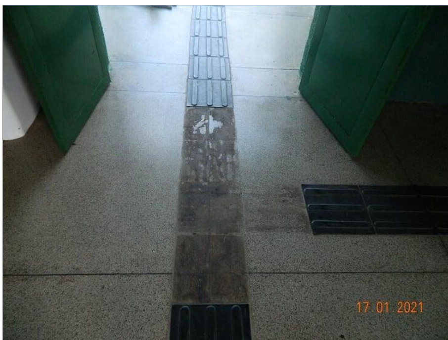
FOTO Nº 033: Ausência de várias peças de piso tátil.
