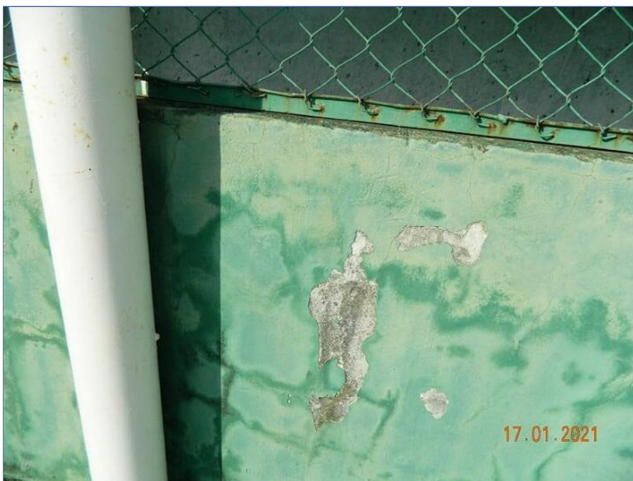
FOTO Nº 194: Descascamento de pintura e sinal de infiltração.
