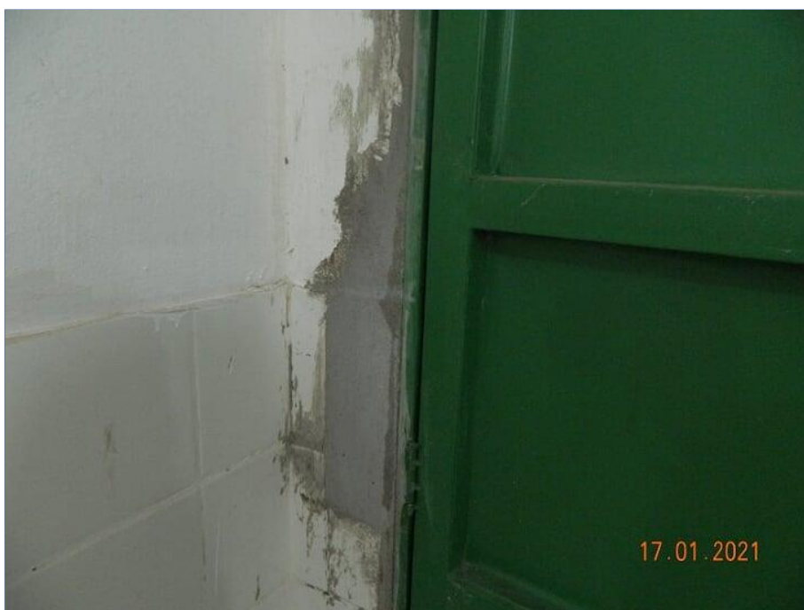
FOTO Nº 107: Pintura e revestimento danificados.
