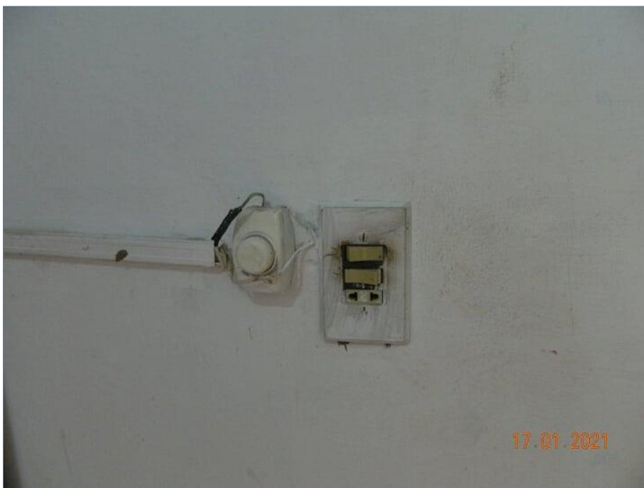
FOTO Nº 057: Instalação elétrica irregular.
