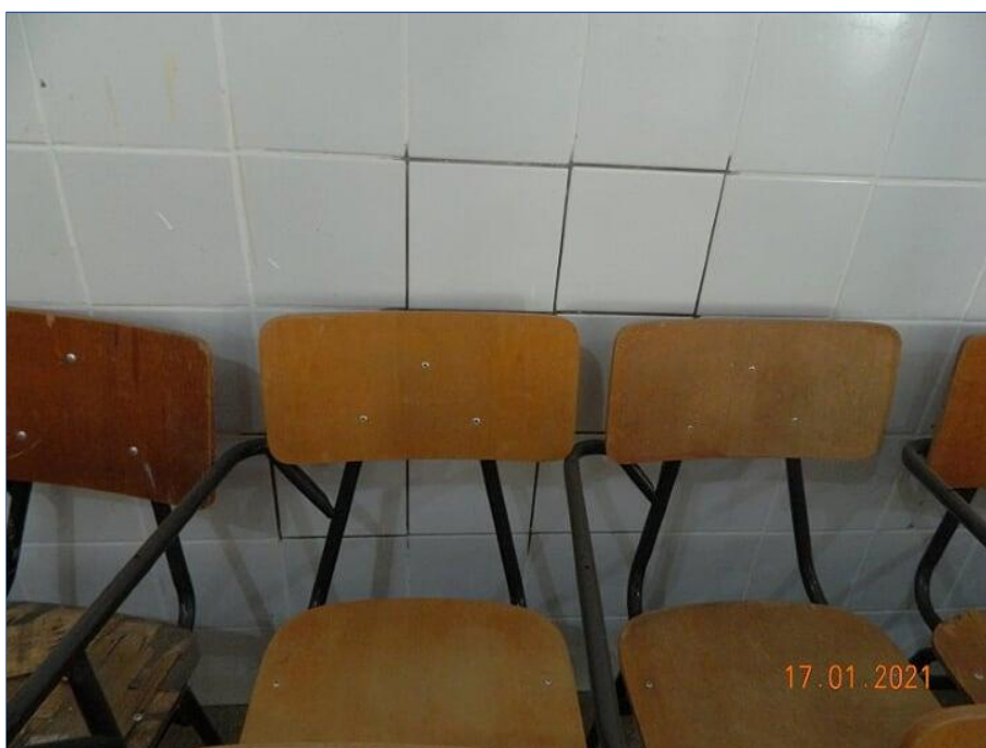
FOTO Nº 102: Revestimento desconforme do original, sem aplicação de rejunte.
