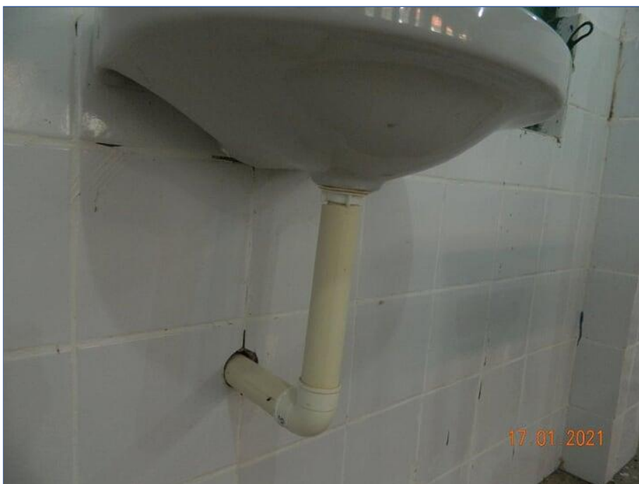
FOTO Nº 112: Instalação hidrossanitária irregular.
