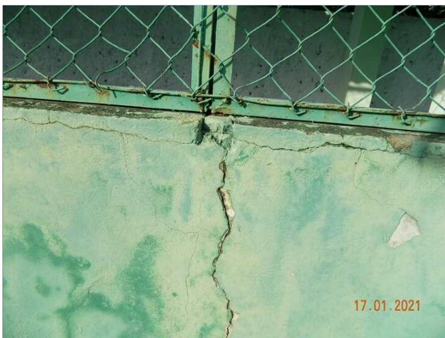
FOTO Nº 195: Rachadura na parede.
