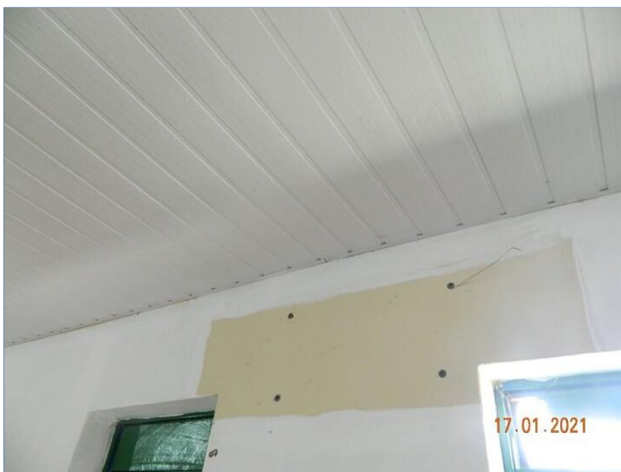
FOTO Nº 145: Parede danificada com pintura irregular.
