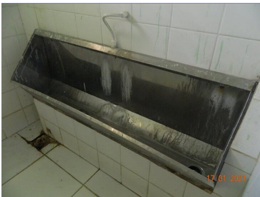
FOTO Nº 138: Mictório sem manutenção.
