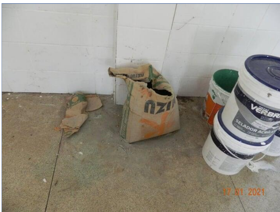
FOTO Nº 090: Material de construção mal acondicionado.
