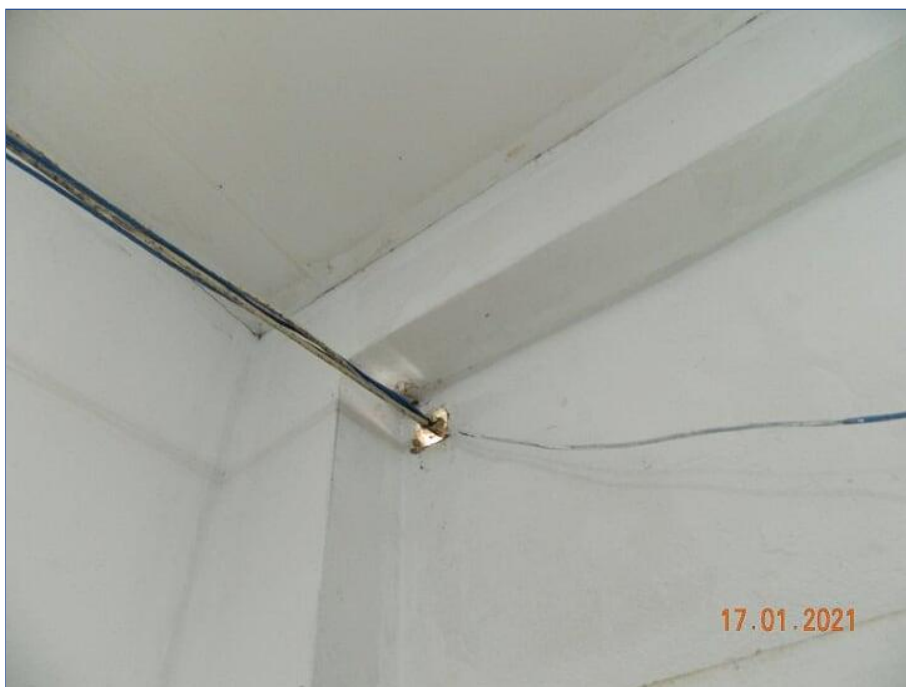
FOTO Nº 068: Parede danificada para instalação de lógica irregular.
