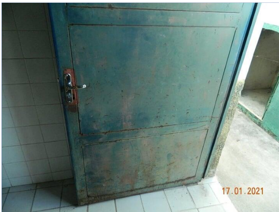
FOTO Nº 173: Porta metálica danificada com sinal de ferrugem.
