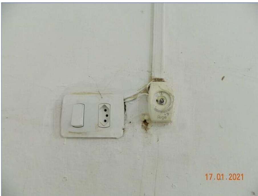
FOTO Nº 094: Instalação elétrica irregular.
