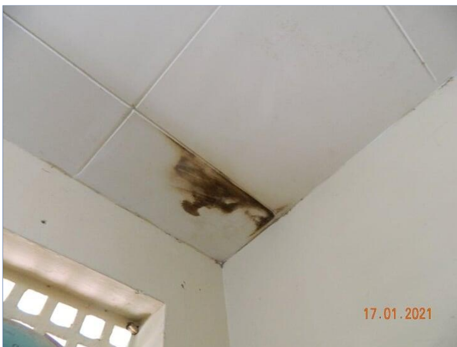
FOTO Nº 051: Sinal de infiltração no forro.
