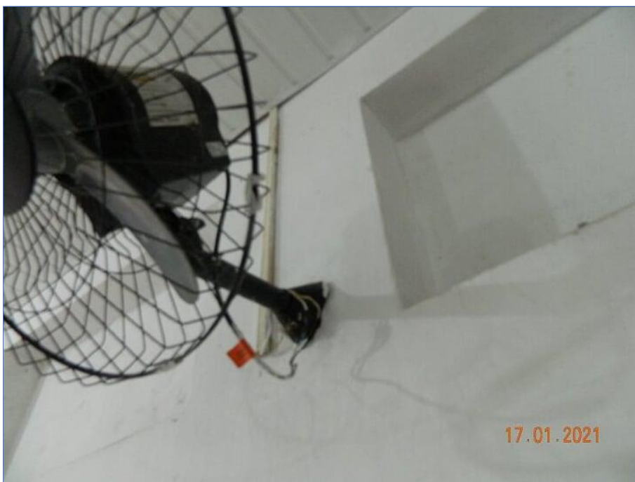
FOTO Nº 030: Instalação elétrica irregular.
