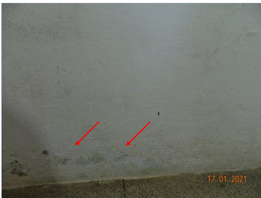
FOTO Nº 041: Pintura deteriorada.
