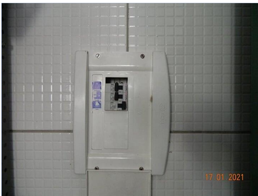
FOTO Nº 187: Quadro elétrico com identificação irregular.
